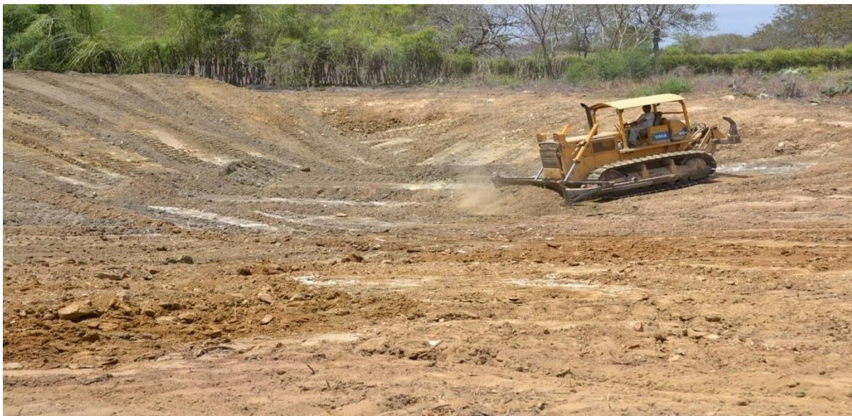
. Figura - 27 - Trator de esteira em operação de recuperação e ampliação de açude
