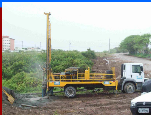
Perfuratriz (perfuração de poço)
