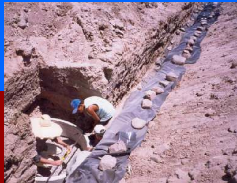
Construção de barragem subterrânea
