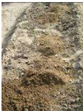
1. Preparo do canteiro
