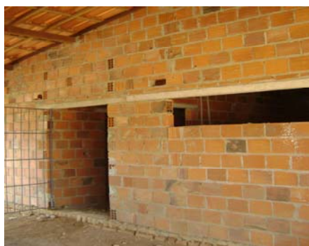
Local onde será instalado do Tanque
