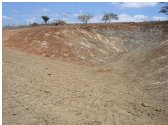
Barragem Frei Jorge
